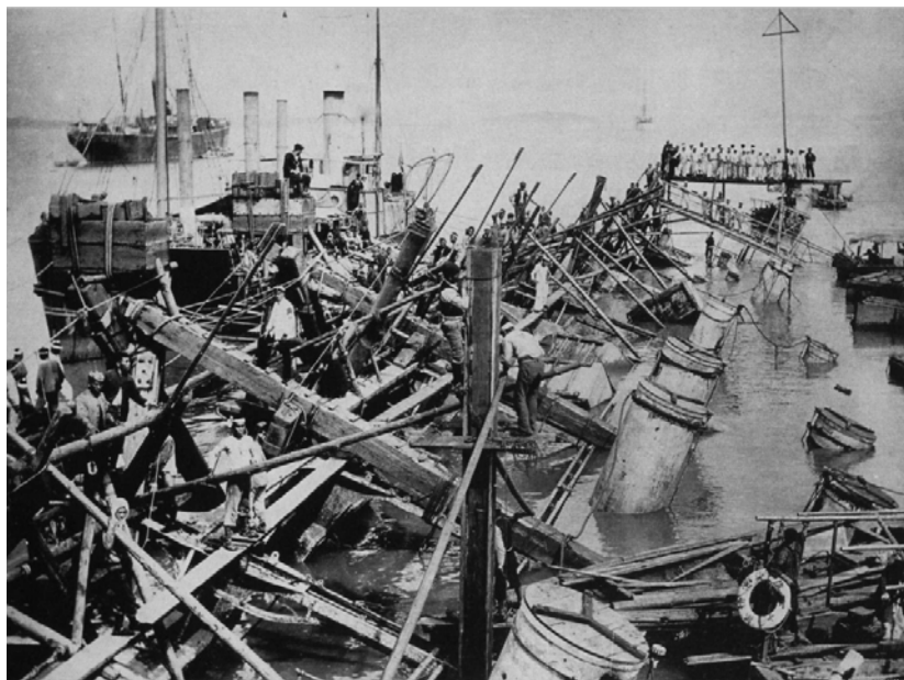
«Варяг». Монтаж кессона
