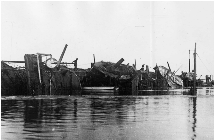
«Варяг», подъемные работы
