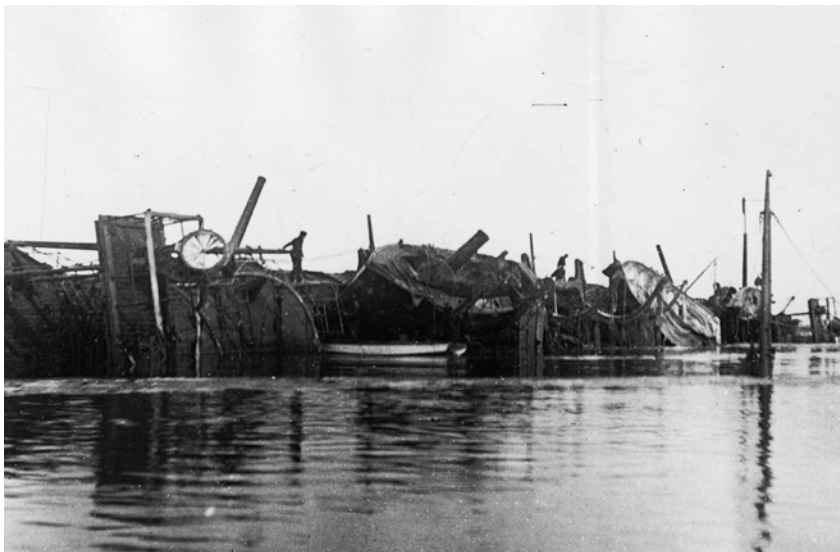
«Варяг», подъемные работы
