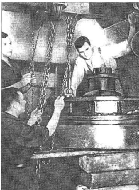
Поход на Ханко в ноябре 1941 года. Аварийная ремонтная работа на «Марти»: С.Е. Костылевский, Е.П. Петров и А.П. Ждановский поднимают крышку цилиндра высокого давления
