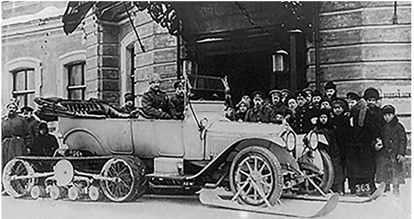
Царский автомобиль «Паккард» (Packard SIX 3-38), переделанный А. Кегрессом в «снеговой мотор», реквизированный большевиками.
